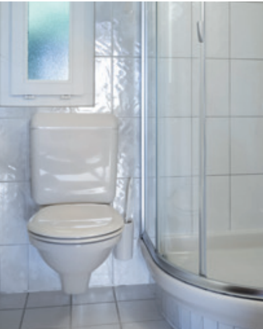
FÖRE Toalett med utanpåliggande cistern
