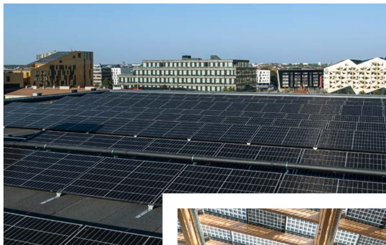
← Solpaneler på taket tillhandahåller grön energi.
