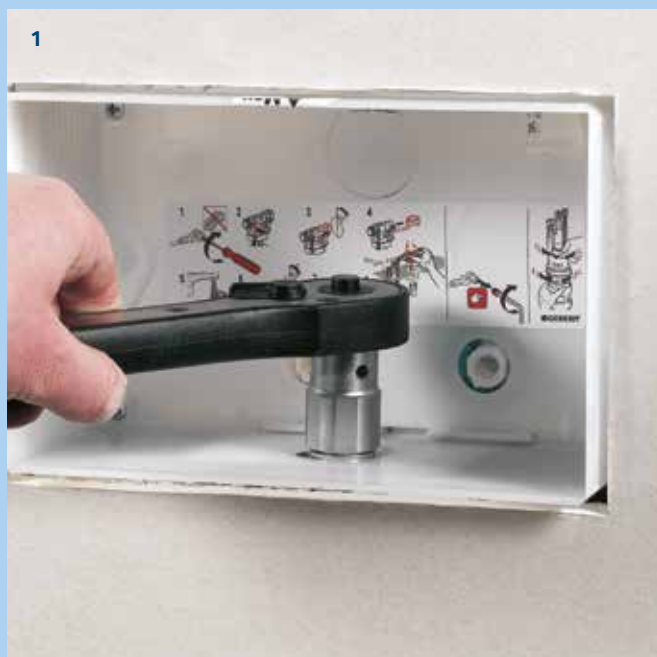
1 Höjden ändras med en justerskruv som är placerad bakom spolplattan. Genom att ta av spolplattan är det enkelt att justera toalettens höjd med upp till 8 cm.
