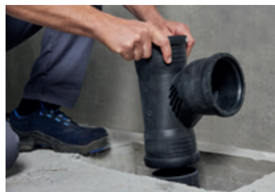
Ett avloppssystem med Geberit Silent-Pro SuperTube installeras.
